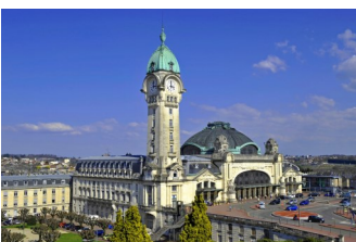
La gare de Limoges
